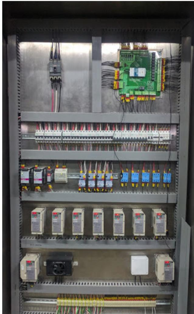
Figura 37. Cofre de control del deshidratador de lodos
